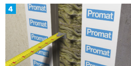
Zmierzyć odpowiednią głębokość.
