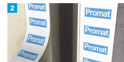
Jeśli to konieczne, zasłonić taśmą obszar roboczy na ścianie lub podłodze.
